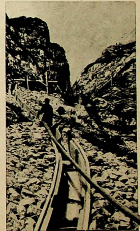
Abb. 8. Einlegen eines HF-Sendekabels
