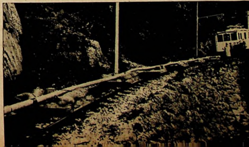
Abb. 9. Transport eines HF-Kabels
